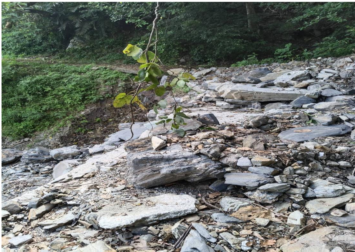
大量土石淤積路面
