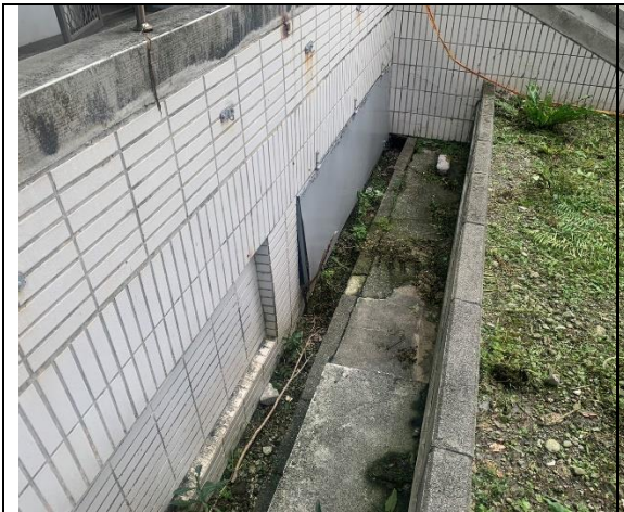
說明：氣窗外水溝保持水溝無雜物
