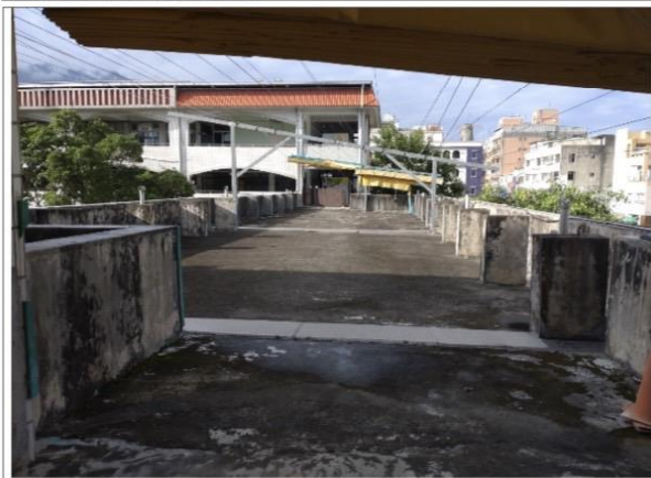
東側二樓通道無監視設備
