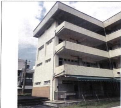
北棟大樓 2F、3F、4F 廁所走廊欄桿全景
