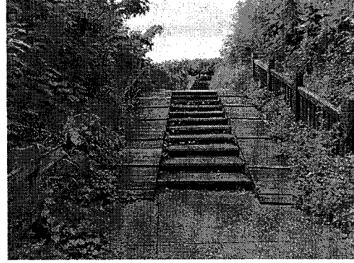
坡頂二斜坡現況
