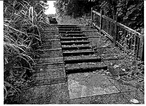
坡頂四斜坡現況
