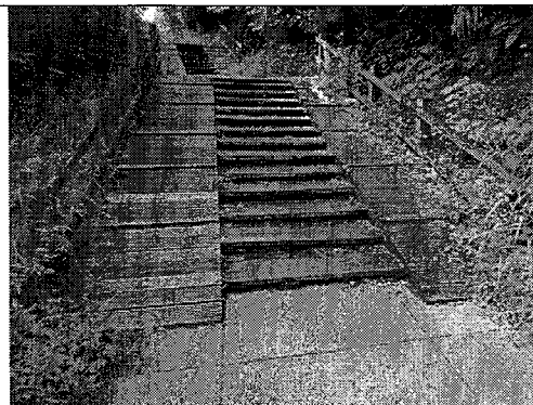
坡頂五斜坡現況
