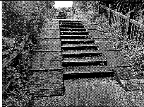
坡頂三斜坡現況
